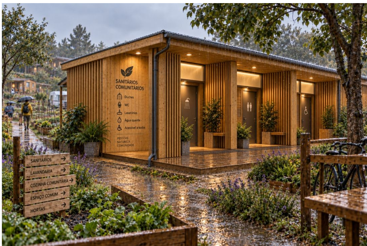
Os sanitários comunitários de um núcleo, em madeira, à chuva: duches, WC, lavatórios, água quente, acessíveis a todos. A aldeia é para viver o ano inteiro, não só de Verão.
